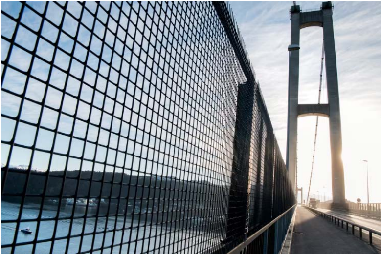
Foto: Bergens Tidende 5. februar 2018
