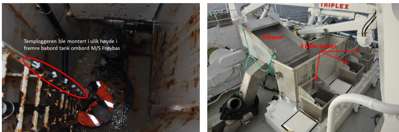
Figur 3. Bilder som viser hvordan temperaturloggerne ble montert i RSW-tank om bord på M/S Frøybas (venstre) og oversikt over silkassen og RSW-tankene om bord på M/S Svebas (høyre). Foto: SINTEF Fiskeri og havbruk.
